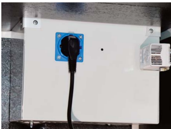
Integrierter Stromanschluss mit Lüftereinheit
